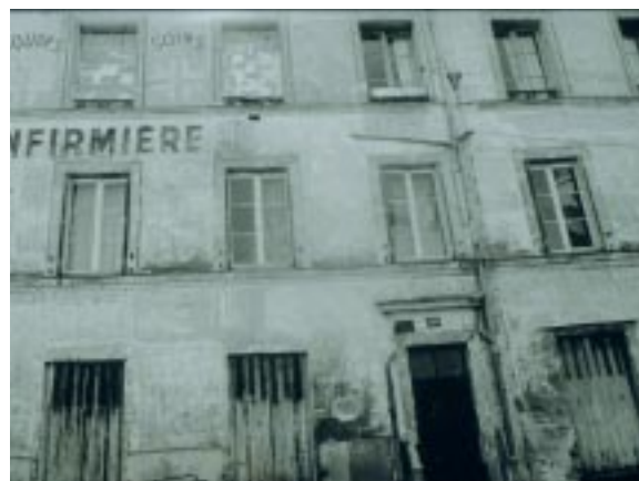
Vue d'un bâtiment municipal dans le XXème arrondissement à Paris, France. (Réf : Le courrier du CNRS "La ville" N°81 Eté 94). > photo CNRS Photothèque
